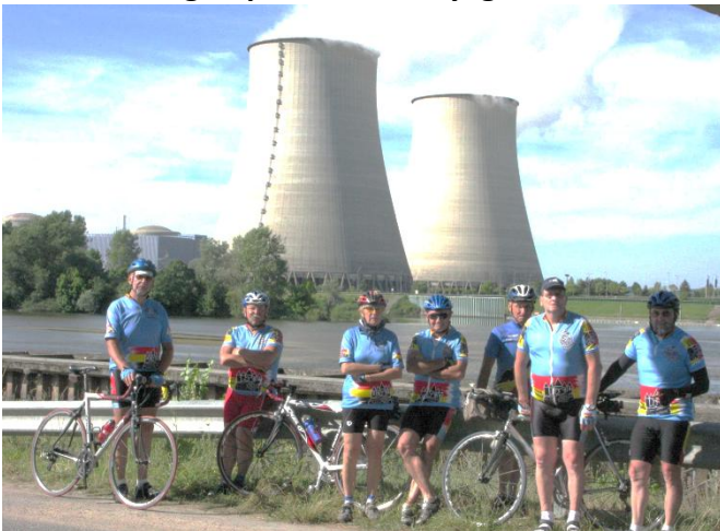
3 Les refroidisseurs de la centrale nucléaire de Belleville sur Loire.
