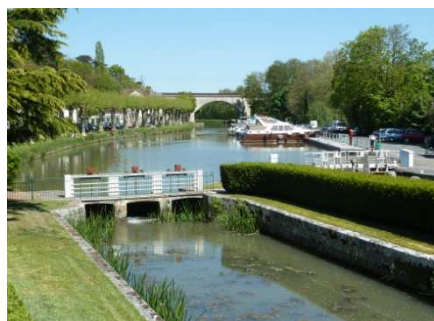
12) Moments au canal du Centre
