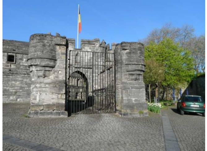
2) 1 er Contrôle à Antoing avec ses carrières, son château
