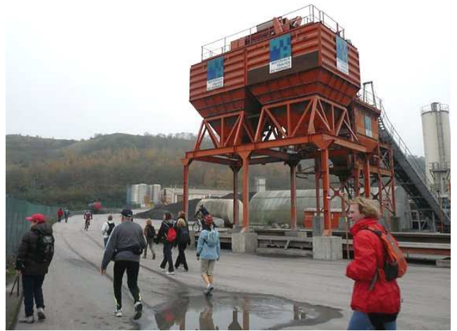
08) Traversée exceptionnelle du chantier ciment.
